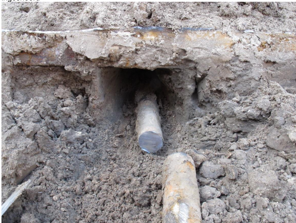
Figuur A.9 Detail van de montage door de damwand.
