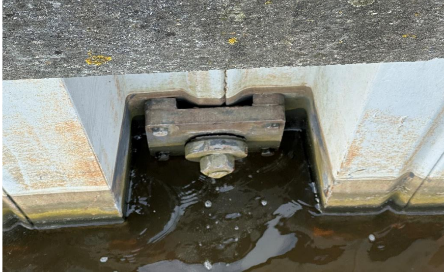
Figuur A 14 Montage aan de buitenzijde van de damwand.
