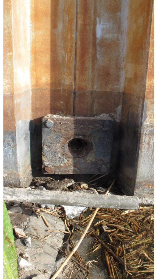
Figuur A.10 Montageplaat door damwand
