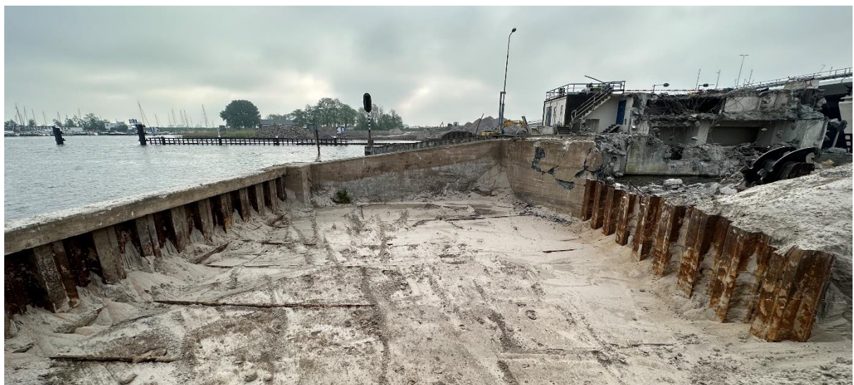
Figuur A.13 Situatie Buitenhoofd-Zuid (links op foto hoofdwand, rechts op foto ankerwand).
