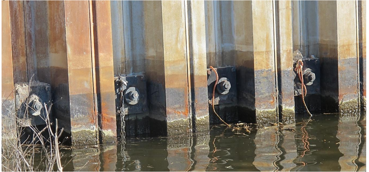
Figuur A.4 Bevestiging aan de damwandzijde.
