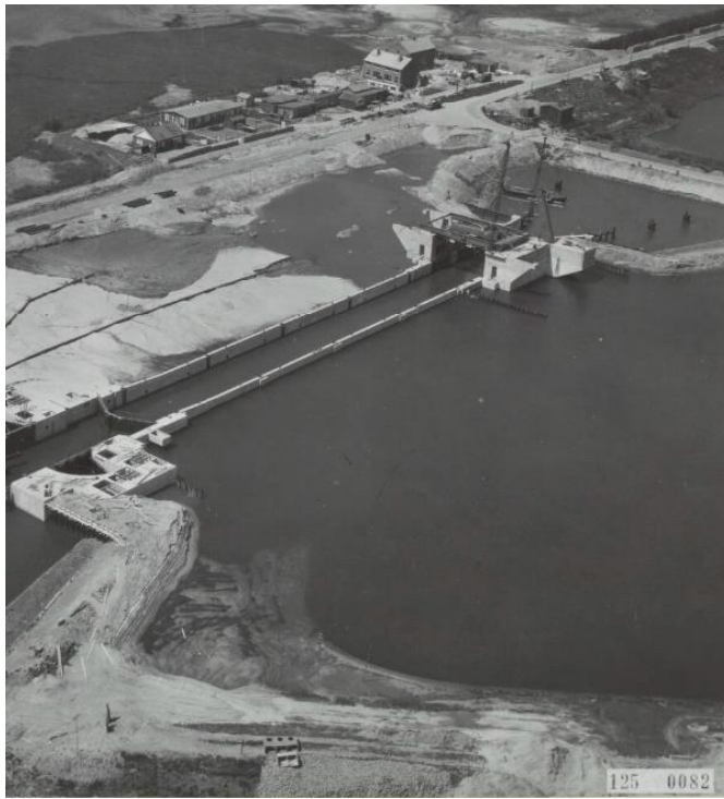
Figuur 2.4 In aanbouw zijnde Roggebotsluis ontgraving voor grondverbetering 4
