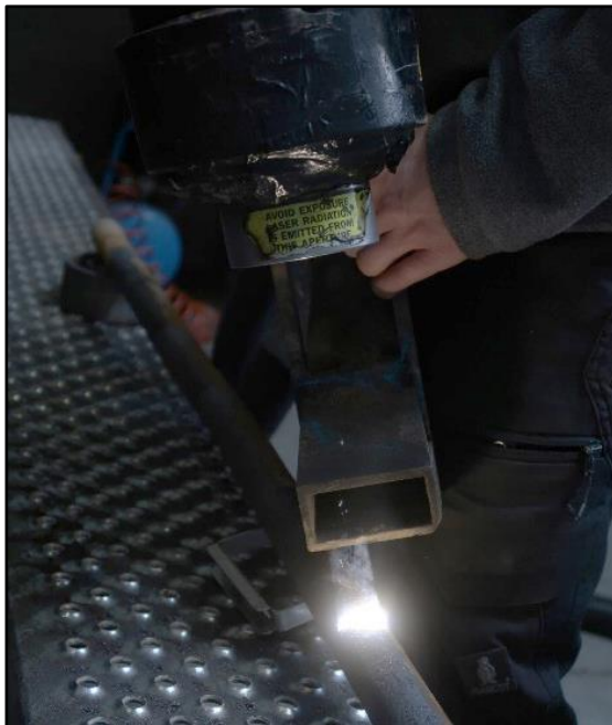
Figuur 2.15 Laserreinigen van een ankerstuk.
