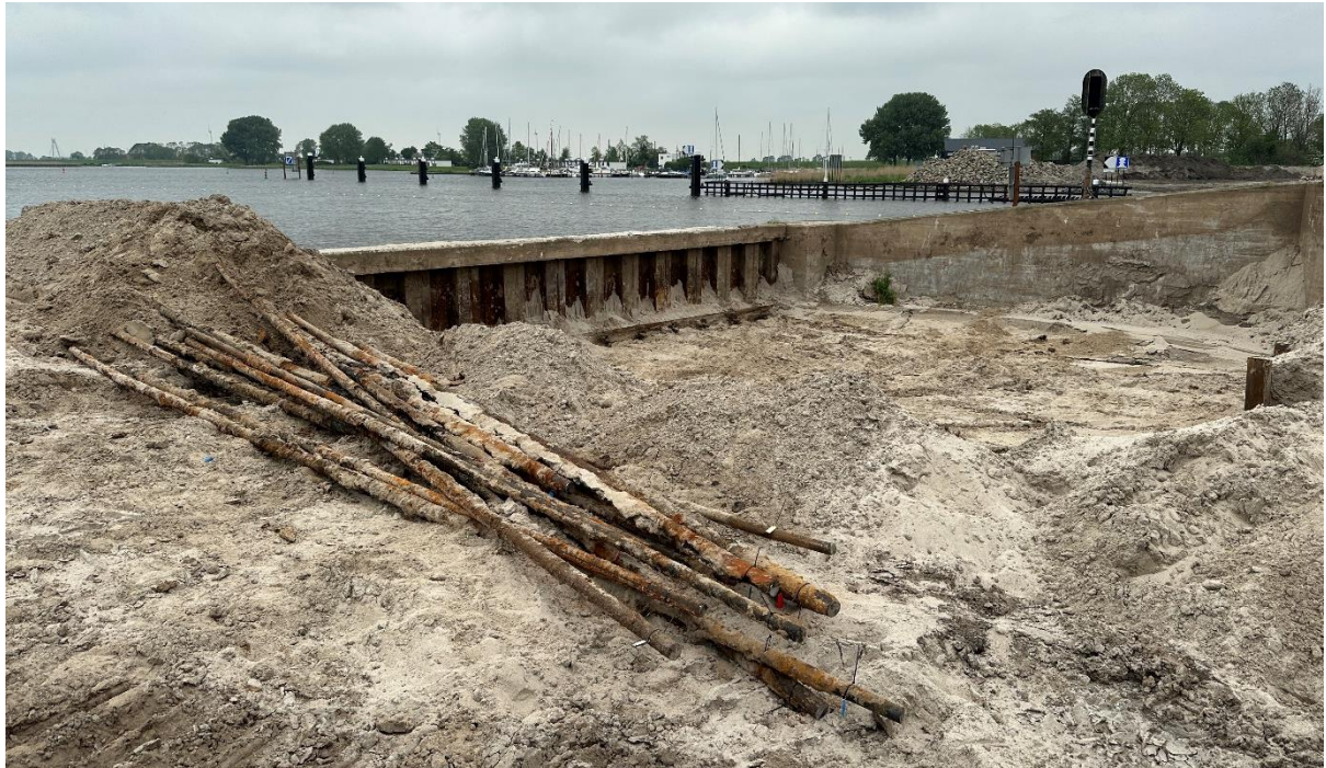
Figuur A.16 Ankerstangen gemarkeerd, verzameld en klaar om opgehaald te worden voor transport.
