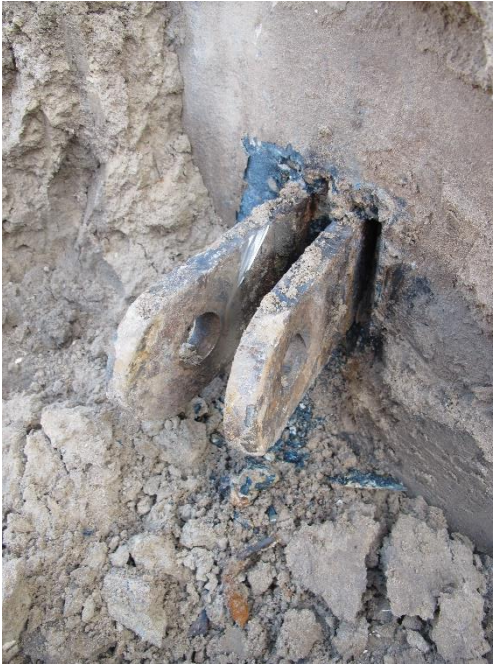
Figuur A.3 Muurbevestiging na verwijderen ankerroog.
