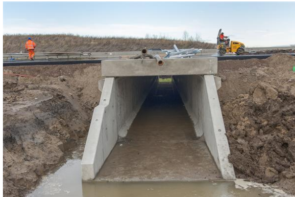
Figuur 2.5 - Aanbrengen van een duiker in Ewijk (Beeldarchief RWS)
