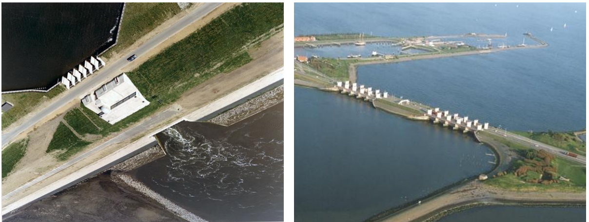
Figuur 3.7 - Links: De Bathse spuisluis, Deltawerken. Rechts: Lorentzsluizen sluizencomplex in de Afsluitdijk (Beeldarchief RWS)
