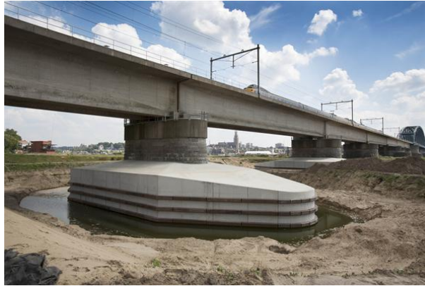
Figuur 2.2 - Brugpijler van de spoorbrug over de Waal bij Lent en Nijmegen (Beeldarchief RWS)
