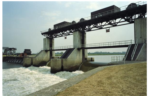
Figuur 3.8 - Links: Stuw Hagestein. Rechts: Stuw (Poiree en Stoney) in Sambeek (Beeldarchief RWS).
